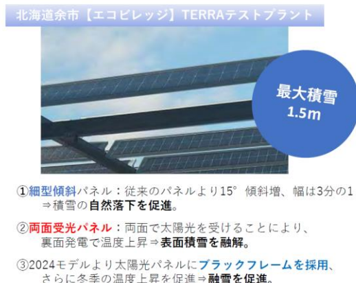
図 7 北海道での細型パネル太陽光発電のテストプラント 出所:株式会社 TERRA
