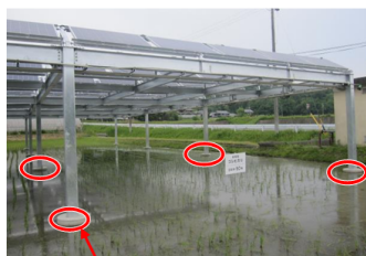
支柱の基礎部分が、一時転用許可の対象
