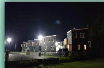
台風被害で停電したが、迅速に復旧した千葉県睦沢市
