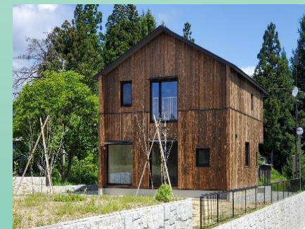
山形県の高断熱省エネ住宅
