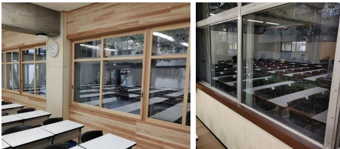
写真1 窓・壁の断熱改修をした教室（左）と隣の未改修の教室（右）
