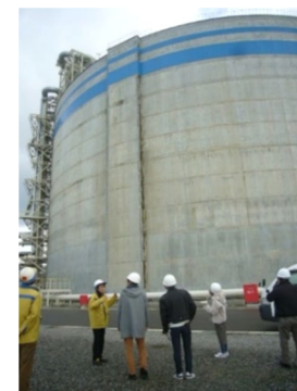
富山新港火力発電所の見学（第13回）（令和元年度）
