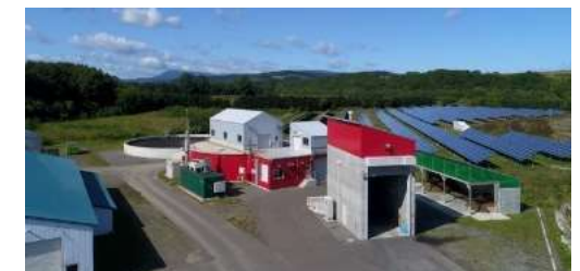
北海道興部町の興部北興バイオガスプラント
